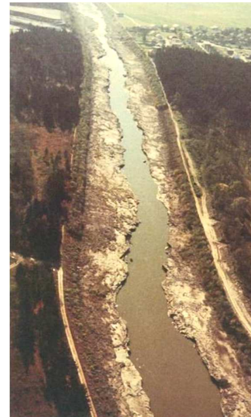
Beispiel für Sohl- und Ufererosion
