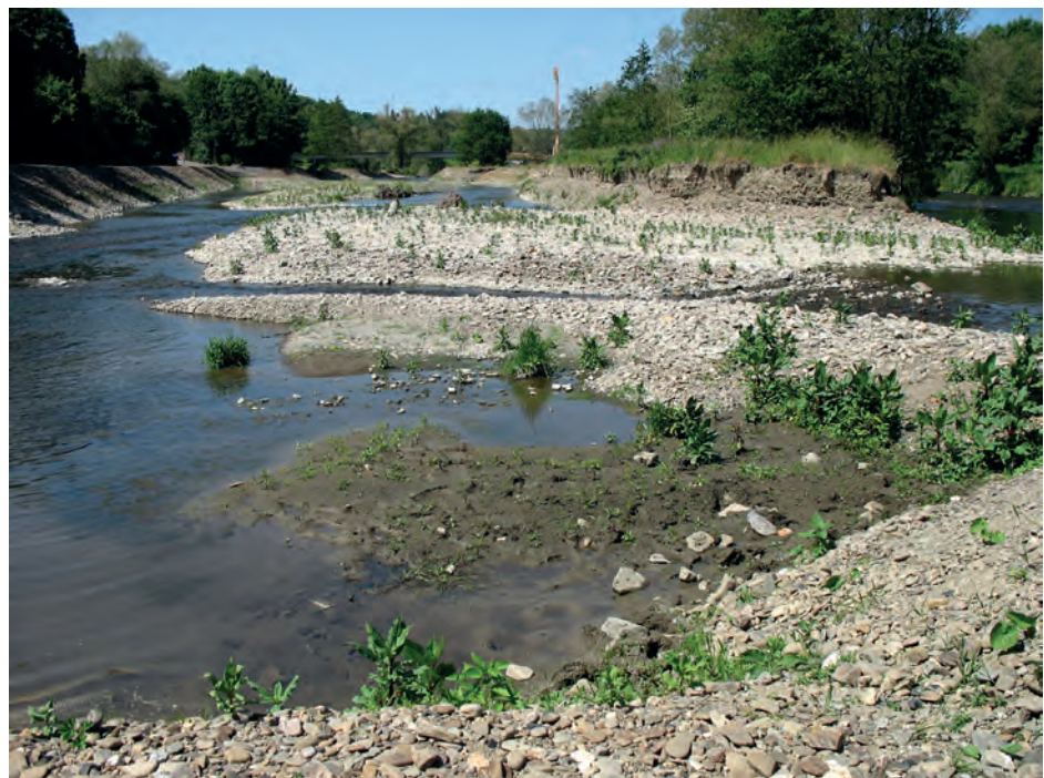
Abb. 1: Renaturierter Abschnitt der Ruhr bei Arnsberg nach Umsetzung der Maßnahme im 2. Bauabschnitt im Sommer 2009 (Foto: K. Januschke).
