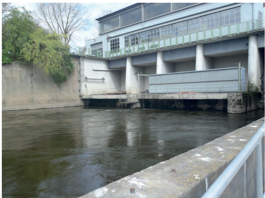
Abb. 1: Wasserkraftanlage Baldeney vom Unterwasser aus (Foto: A. Hoffmann)
