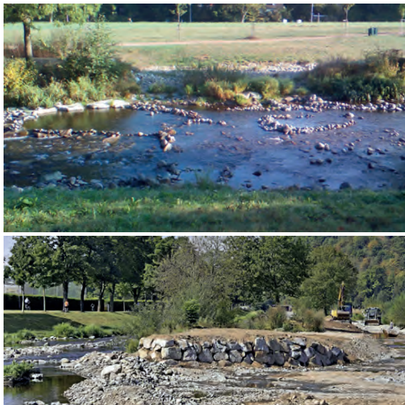
Abb. 2: Anthropogene Eingriffe in die Gerinnemorphologie (Becken, oben). Befestigungsmaßnahmen im Gewässerbett 2016, zwei Jahre nach Fertigstellung der Entwicklungsmaßnahme (unten) (Fotos: Hydrologie, Universität Freiburg).
