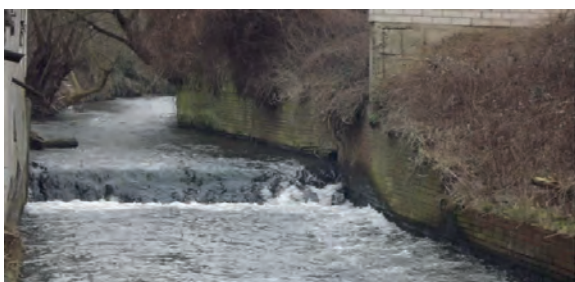
Abb. 1: Beispiel für ein Durchgängigkeitshindernis (Absturz im Kreuzau-Niederrau-Dürener Mühlenteich bei Düren; Foto: LANUV NRW)
